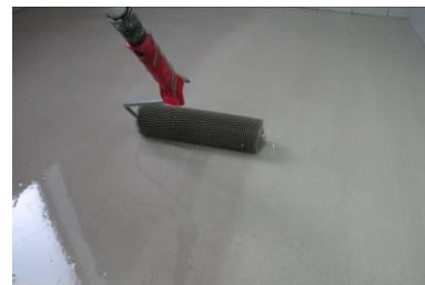
Uniformização da superfície c/ rolo de bicos
