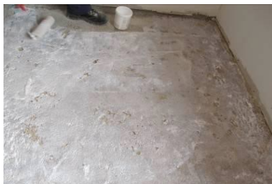
Aplicação do primário MICROART AD 21
