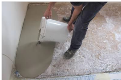
Aplicação do PLAN LEVEL 315
